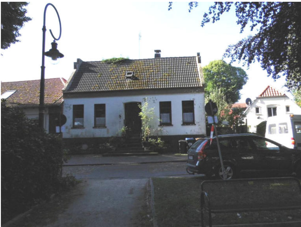
Bild Nr. 12: Am Wall 3
